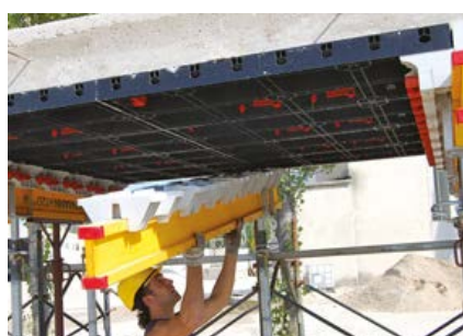
⑥ RIMOZIONE TRAVETTO H
