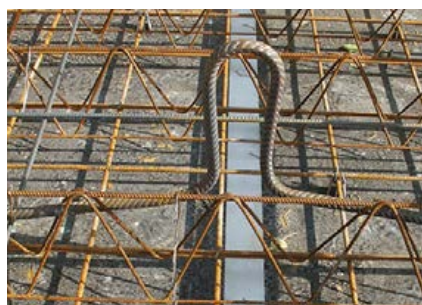
④ POSA ARMATURA
