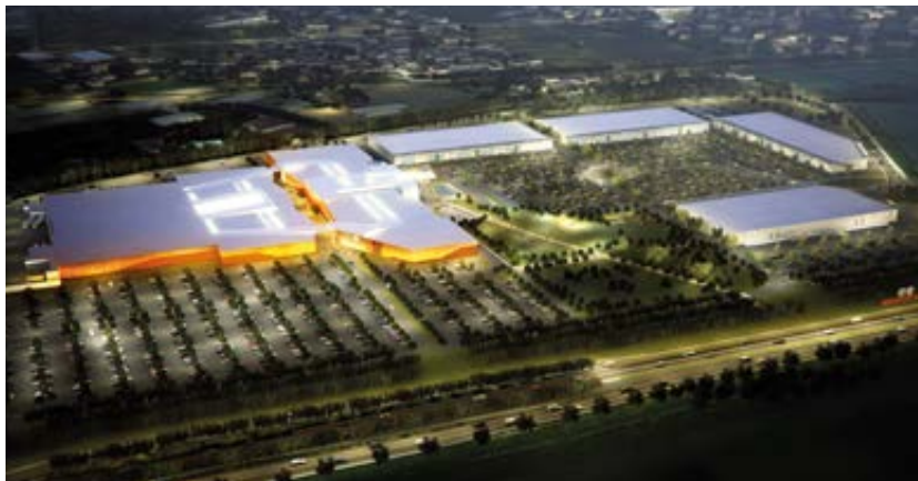
ELEVATOR TANK Centro Commerciale MondoJuve TORINO, ITALIA
