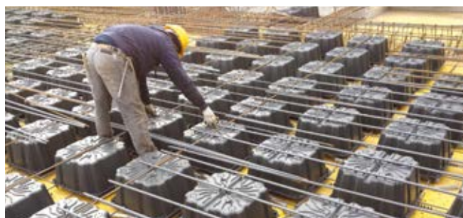
④ COMPLETAMENTO POSA ARMATURA
