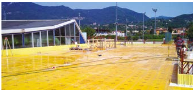
① PREPARAZIONE IMPALCATO DI BASE
