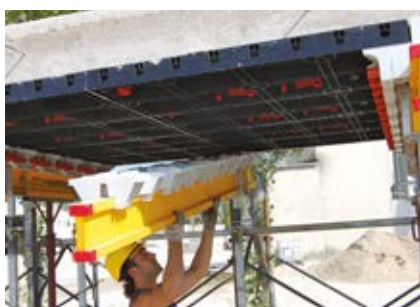
⑥ RIMOZIONE TRAVETTO H
