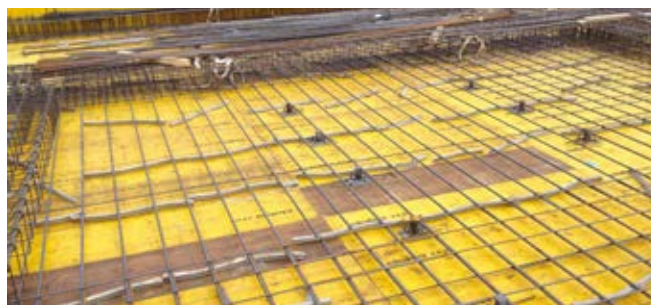
② POSA ARMATURA INFERIORE E ZONE PIENE
