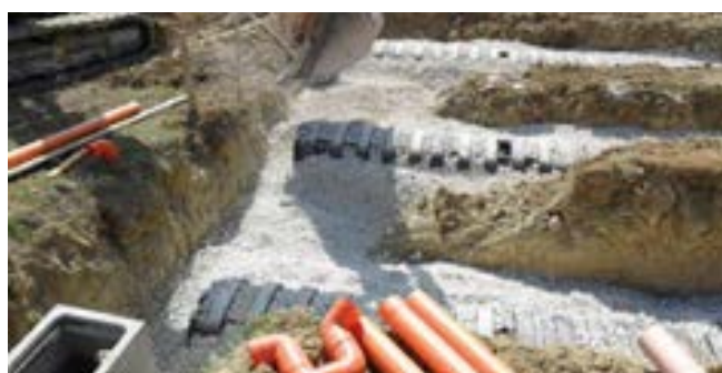
④ RICOPRIMENTO Innesto tubi di alimentazione e di ventilazione. Ricoprimento con almeno 15 - 20 cm di ghiaia 20/40 mm.
