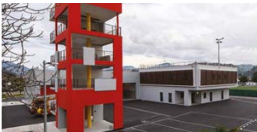
ELEVATOR TANK Centro di Antincendio e Soccorso SAINT-LAURENT-DU-VAR, FRANCIA
