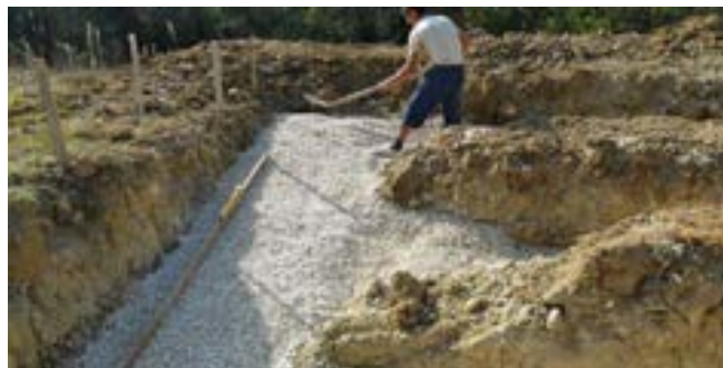
② STESURA GHIAIA Stesura ghiaia 20/40 mm (spessore minimo 10 cm).
