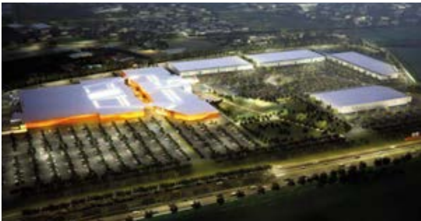
ELEVATOR TANK Centro Commerciale MondoJuve TORINO, ITALIA
