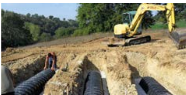
③ POSA DRENING Posa delle camere Drening.
