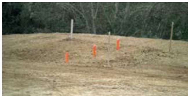
⑥ RINTERRO Rinterro fino a raggiungimento del piano campagna.
