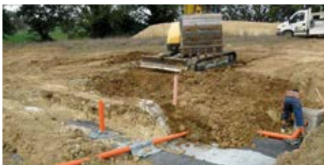
⑤ POSA DI GEOTESSUTO Posa del geotessuto su tutta la superficie.
