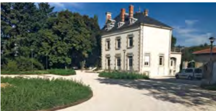
GEOGRAVEL, 600 m 2 Fédération Départementale des Chasseurs de la Loire ANDRÉZIEUX-BOUTHÉON, FRANCE
