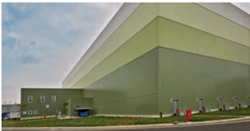
NUOVO ELEVETOR Stabilimento Santex Sarego VICENZA, ITALIA
