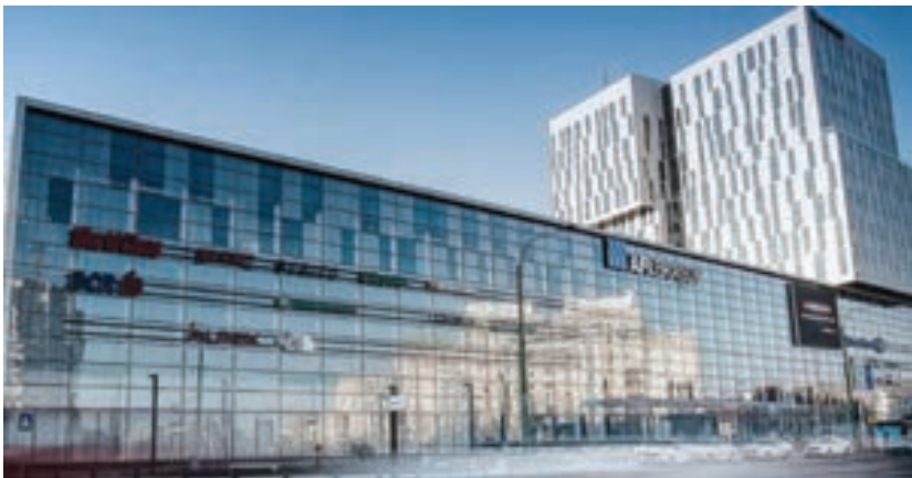
MULTIMODULO Centro Commerciale AFI BRASOV, ROMANIA
