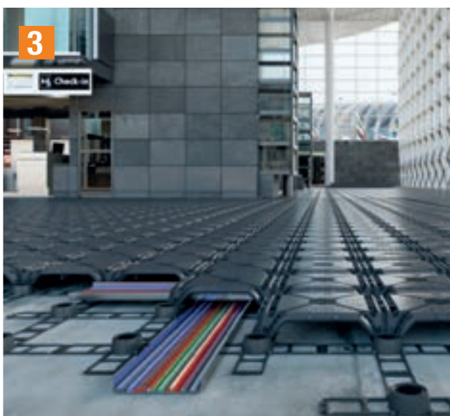
3 Semplificazione nella posa di estese superfici grazie alla rapidità e precisione del sistema senza l'ausilio di strumentazione a laser.
