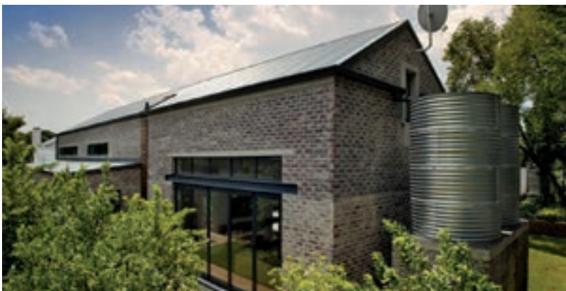
MODULO The Link House CENTURION, SUDAFRICA
