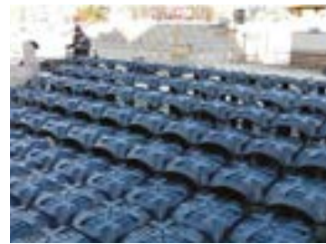
Detalle instalación de los encofrados
