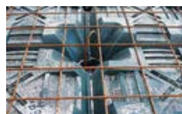
Refuerzo del pilar armadura
