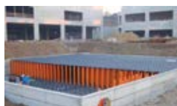
Tanque de acumulación de agua de lluvia hasta 300 cm
