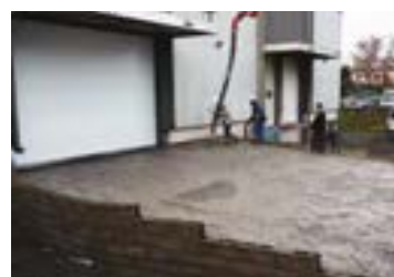
Rampa con inclinación acabada
