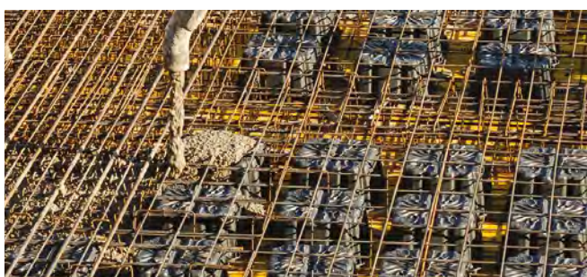
⑤ PREMIÈRE PHASE DE COULAGE
