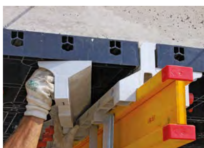
⑦ ENLEVEMENT DES BORDURES
