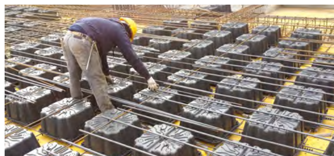
④ ACHÈVEMENT DE LA POSE ARMOUR
