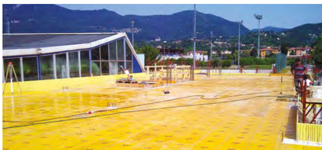
① LA PRÉPARATION DE LA BASE
