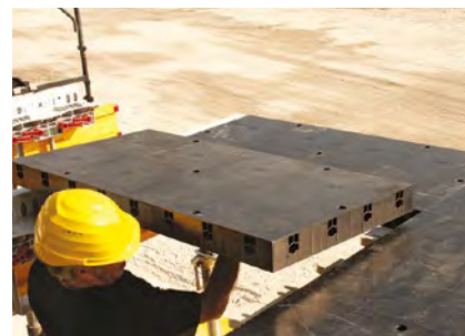
③ POSE DE PANNEAUX GÉOPANNEAUX
