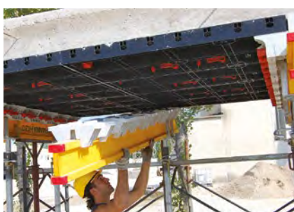
⑥ ENLEVEMENT DES JOISTES H
