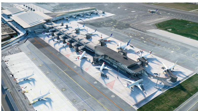
Oslo Gardemoen Ausbau Nicht-Schengen-Ost OSLO, NORWEGEN
