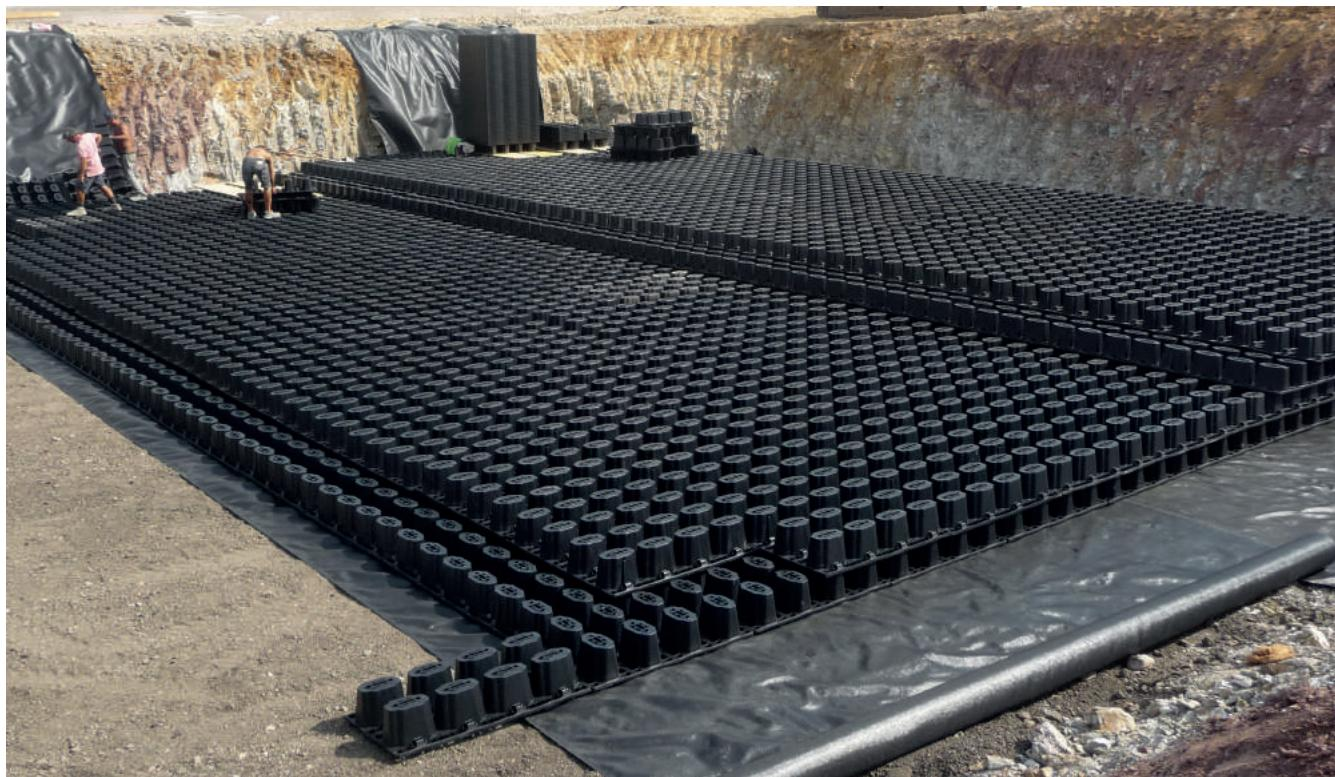
Drainpanel ist ein modulares Element für die Ableitung, Rückgewinnung und Wiederverwendung von Regenwasser. Die Module werden auf mehreren Ebenen übereinander gelegt, ohne dass spezielle Verbindungen oder Fugen erforderlich sind.
