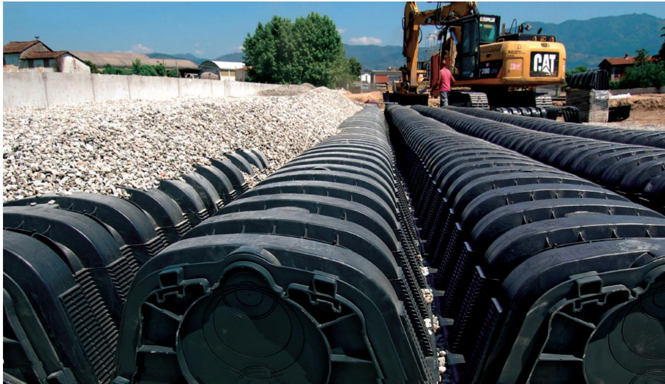
Drening ist so konzipiert, dass es in Bereichen mit einer großen Einsickerungsfläche installiert wird. Das System besteht aus einer Reihe von miteinander verbundenen Tunneln und einem Stopfen an beiden Enden jeder Reihe von Elementen. Die Installation erfolgt auf einer Ebene.
