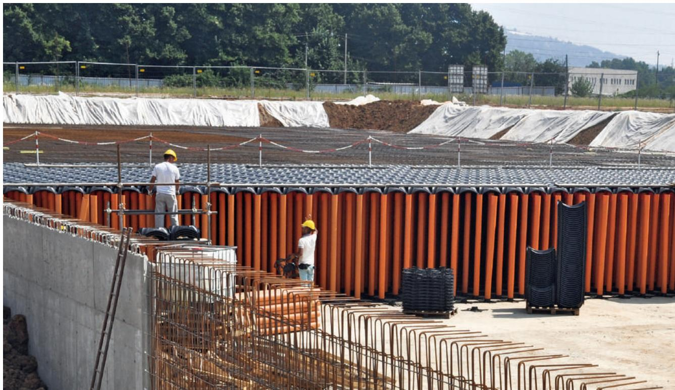
Elevator Tank ist ein System, das eine doppelte Aufgabe erfüllen soll: die städtische Umwelt vor Überschwemmungen und Überflutungen zu schützen und gleichzeitig Regenwasser, das durch verschiedene Niederschläge entsteht, in seinem Inneren zu speichern.
