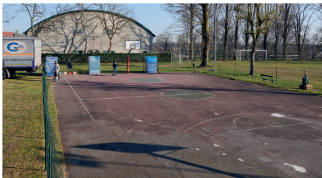
① PRÉPARATION DU FOND Nettoyage et nivellement de la surface.
