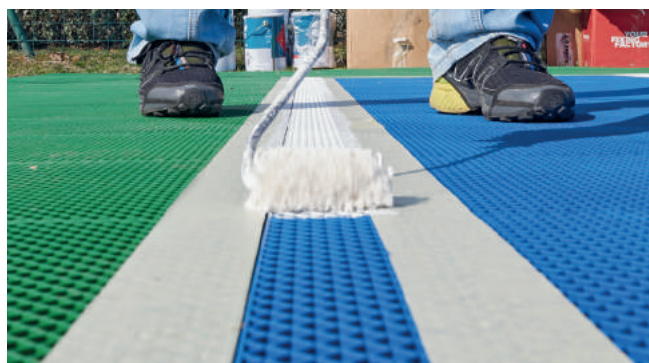
④ TRAÇAGE DES LIGNES Traçage des lignes avec peinture routière au rouleau ou pinceau.
