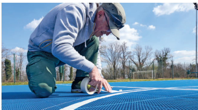
③ DÉLIMITATION DU TERRAIN Marquage des guides avec ruban papier et réalisation des lignes avec peinture routière. Pour les manifestations temporaires on utilise, en revanche, un ruban adhésif spécifique en PVC.
