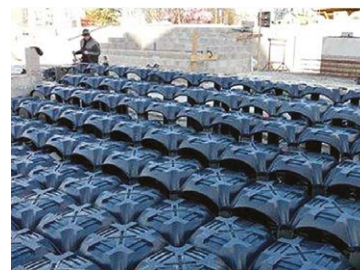
Detalle instalación de los encofrados
