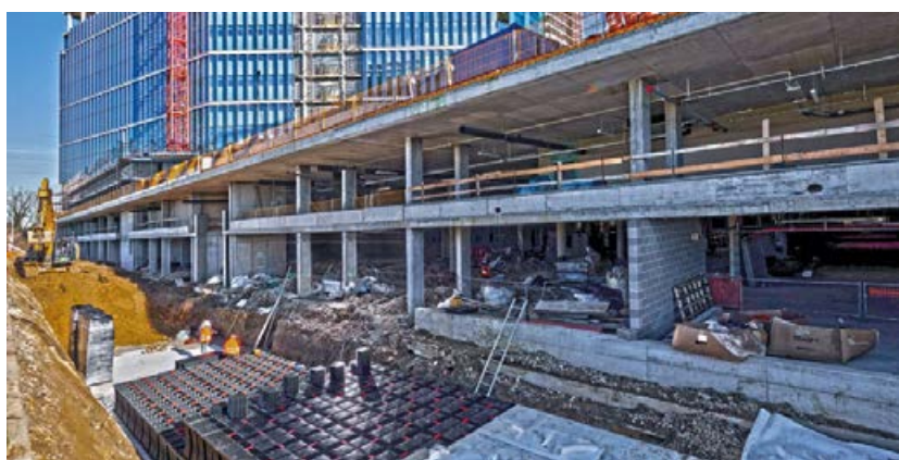
Bacino di infiltrazione acque meteoriche (1000 m 3 ) Fase di installazione moduli BUSINESS CENTER, MILANO
