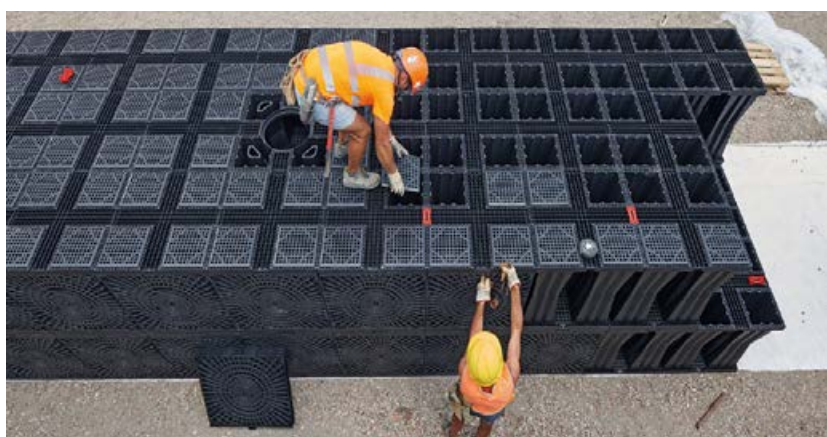
Bacino di infiltrazione acque meteoriche (130 m 3 ) Fase di chiusura superiore moduli NUOVA URBANIZZAZIONE, TRENTO
