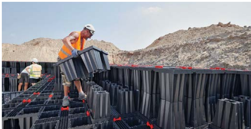
Bacino di laminazione acque meteoriche (800 m 3 ) Fase di installazione moduli AEROPORTO ORIO AL SERIO, BERGAMO
