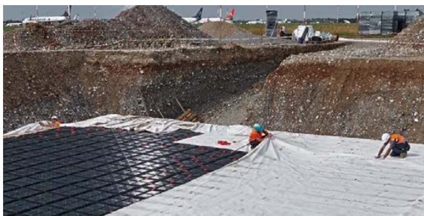
Bacino di laminazione acque meteoriche (800 m 3 ) Fase di copertura con geotessuto AEROPORTO ORIO AL SERIO, BERGAMO
