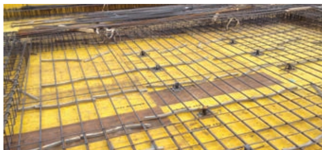
② POSA ARMATURA INFERIORE E ZONE PIENE
