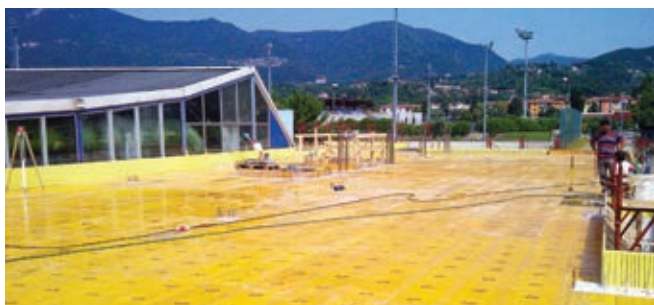
① PREPARAZIONE IMPALCATO DI BASE
