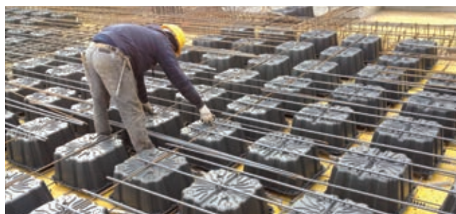
④ COMPLETAMENTO POSA ARMATURA
