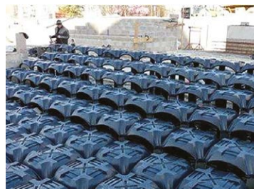
Detail d'installation des caissons
