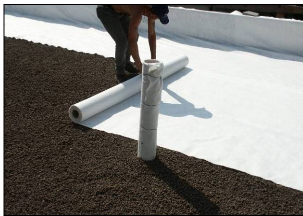
Fig. 2 Posa del tessuto-non-tessuto di separazione
