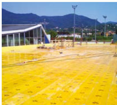
① PREPARAZIONE IMPALCATO DI BASE
