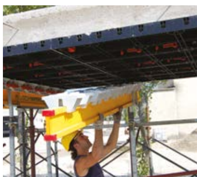
⑥ RIMOZIONE TRAVETTO H
