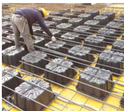
④ COMPLETAMENTO POSA ARMATURA
