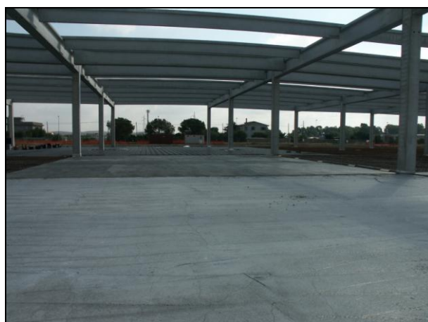
Fig. 2 Finished pour
