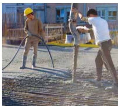
⑦ DEUXIÈME COULAGE DE BÉTON
