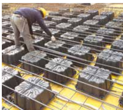
④ ACHÈVEMENT DE LA POSE DE L'ARMATURE
