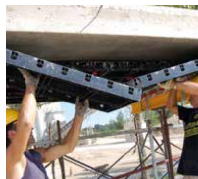
⑧ DÉCOFFRAGE PANNEAUX GEOPANEL
