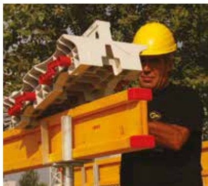
① INSTALLATION POUTRELLES Y + CALE
