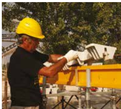
② INSTALLATION POUTRELLES H
