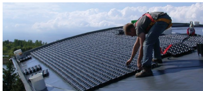
Figura 12 - Installazione Drainroof
