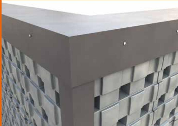
Positionieren Sie den Streifen Plastikkartons auf dem Scheitelpunkt der Paneele DEFENDER und fixieren Sie auch diese Paneele mittels selbstschneidender Schrauben.
