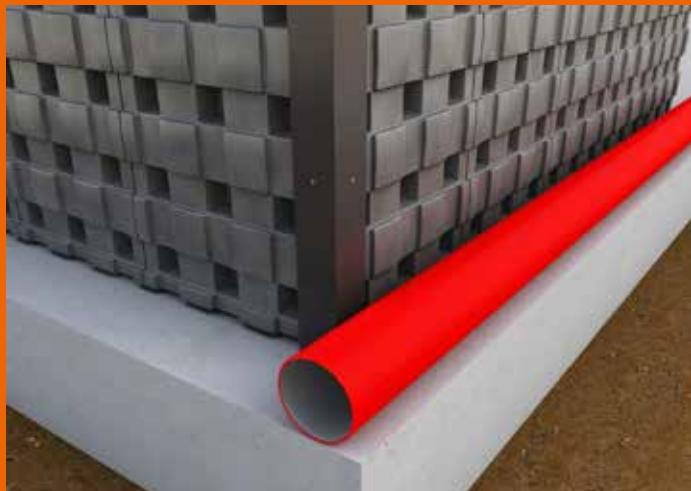
Verlegen Sie einen Rohr, der mit einem Sickerbecken verbunden ist, entlang des gesamten Umfangs des Gebäudes.
