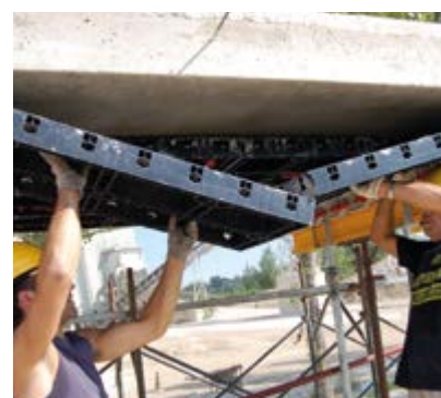
⑧ РАСПАЛУБКА ПАНЕЛЕЙ GEOPANEL
