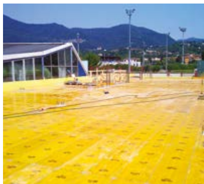
① ПОДГОТОВКА БАЗОВЫХ ЛЕСОВ
