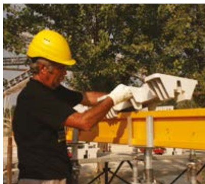
② УКЛАДКА ПОПЕРЕЧИН H
