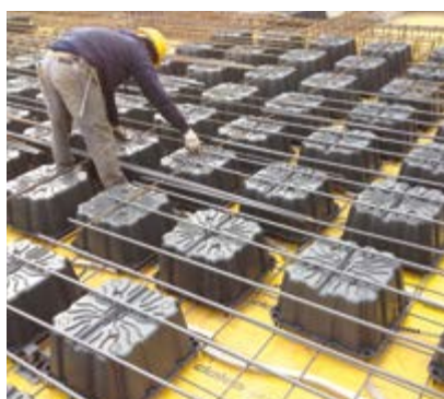
④ ЗАВЕРШЕНИЕ УСТАНОВКИ АРМАТУРЫ
