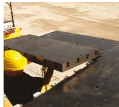
③ УКЛАДКА ПАНЕЛЕЙ GEOPANEL
