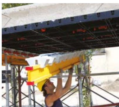
⑥ УДАЛЕНИЕ ПОПЕРЕЧИНЫ H
