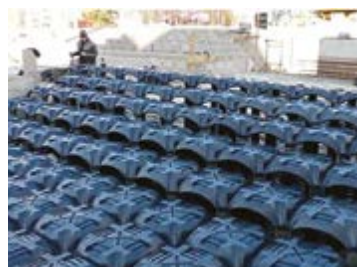
Detail d'installation des caissons
