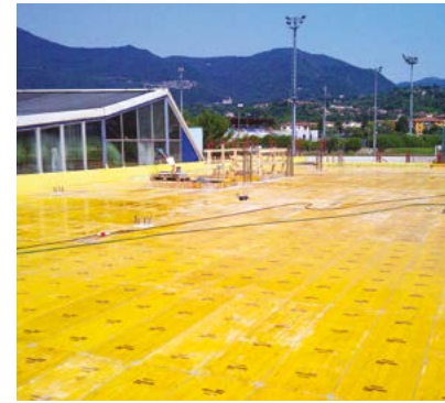
① PREPARACIÓN TABLERO DE BASE
