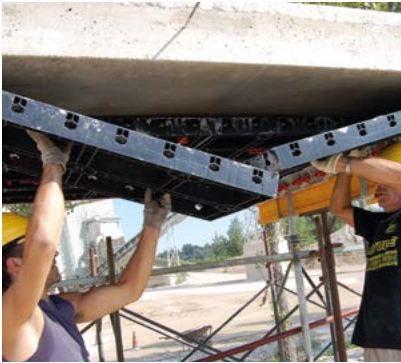
8 DESENCOFRADO PANELES GEOPANEL
