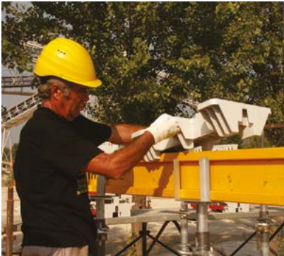
2 COLOCACIÓN VIGUETAS H
