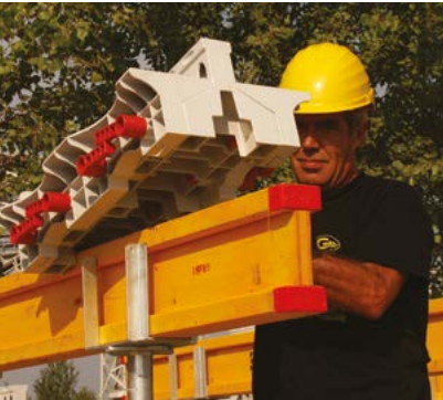
1 COLOCACIÓN VIGUETAS Y + CUÑA
