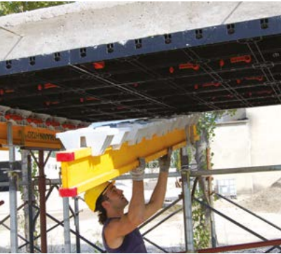
6 RETIRADA VIGUETA H
