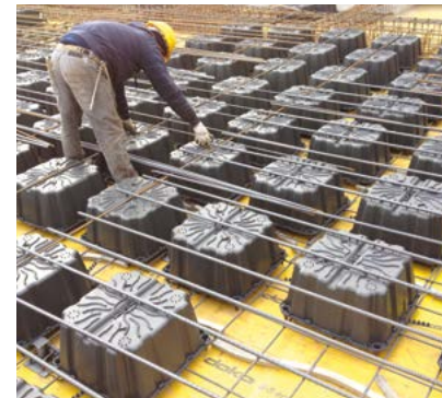
④ TERMINACIÓN COLOCACIÓN ENCOFRADO
