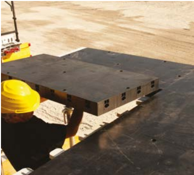
3 COLOCACIÓN PANELES GEOPANEL
