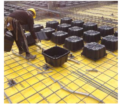
③ COLOCACIÓN NUEVO NAUTILUS
