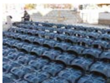
Dettaglio posizionamento casseri
