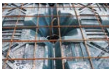
Rinforzo del pilastro con armatura
