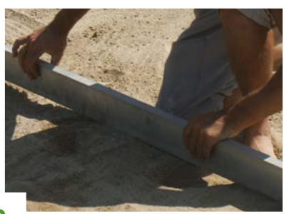
2 Rédaction d'un lit de pose (au moins 10 cm) en sables volcaniques ou siliceux enrichis avec du fumier organique
