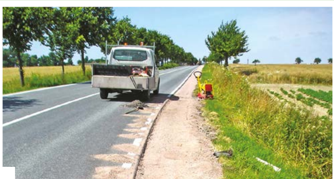
1 RÉALISATION D'UN FOND PORTANT, QUI RÉSISTE AUX SOLlicitATIONS DES VÉHICULES
