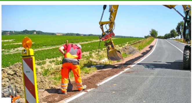
3 COUVERTURE DE GEOROAD AVEC PIERRAILLE EN GRAIN FIN. IL EST AUSSI POSSIBLE D'ENGAGONNER LA SURFACE
