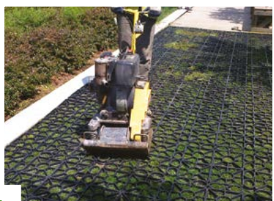
5 ROULEMENT AVEC UN ROULEAU MÉCANIQUE APRÈS L'IRRIGATION
