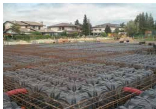
Posa sistema MODULO e GEOBLOCK
