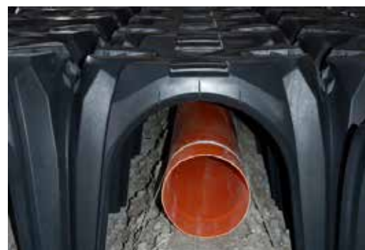
Dettaglio tubo di ventilazione
