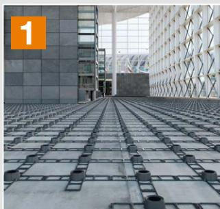
Posa delle griglie nell'area edibita alla realizzazione della pavimentazione flottante.
