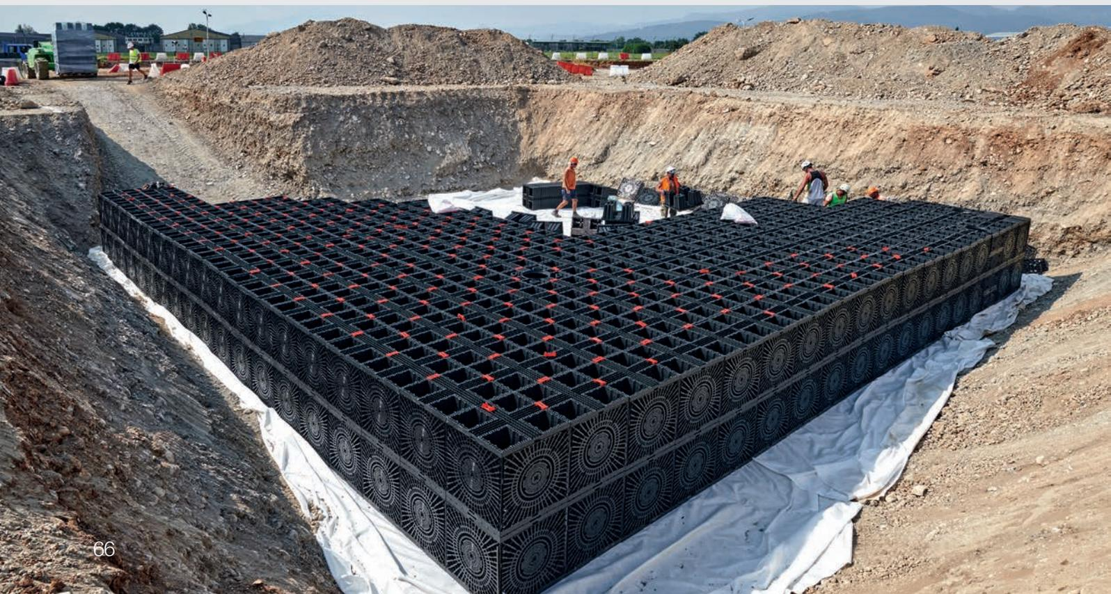
**ELEMENTO MODULARE A STRUTTURA TRONCOPIRAMIDALE CAVA**
