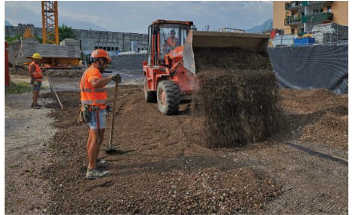
Lo strato superiore deve avere un grado di compattazione  $D_{pr} \geq 97\%$  ( $E_{vd} \geq 25 \text{ MN} / \text{m}^2$  or  $\text{CBR} \geq 8\%$  strato superiore). Se il terreno viene incluso nel calcolo di infiltrazione, la permeabilità è corrispondente anche al grado di compattazione del materiale di riempimento (categorie di suolo GE, GW, SE, SW, SI).
